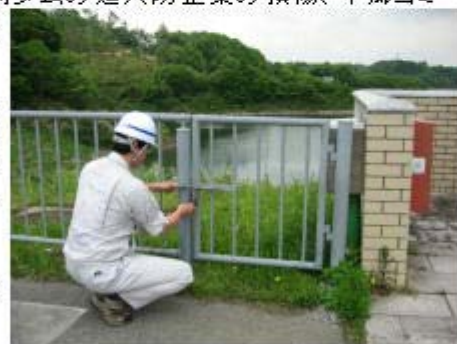
安全点検の様子
