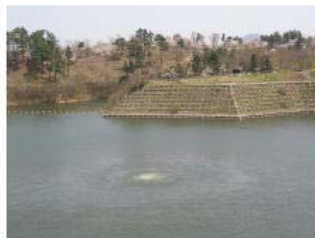
さくら湖でブクブクして見える白い泡の様なものが浅層循環施設です。さくら湖には5機設置しています。
