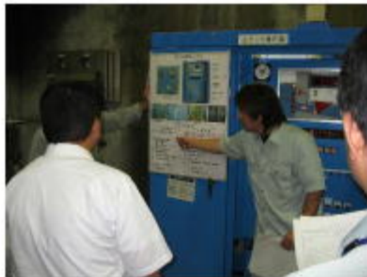
設備点検説明状況
