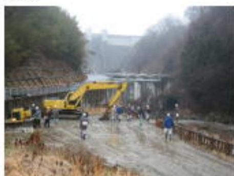
現場2（堤体下流）
