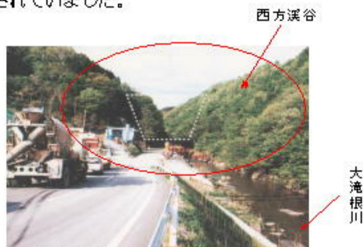
三春ダム直下流から撮影した写真です。白い点線の部分が現在の堤体になります。
