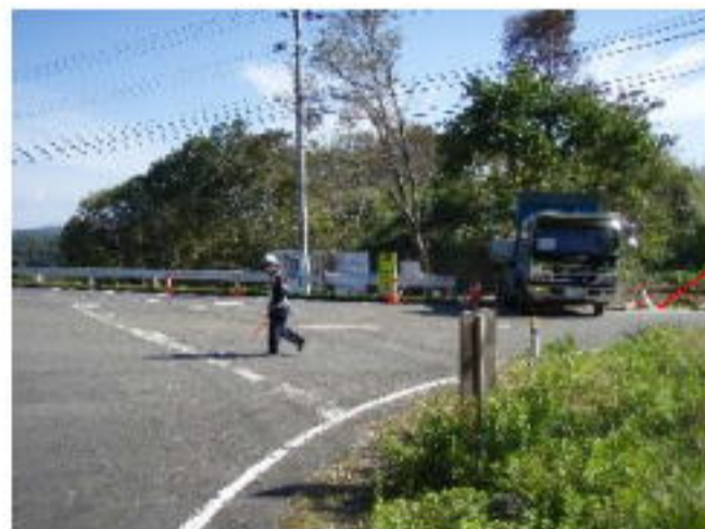
管理所入口（門扉）の工事状況写真
