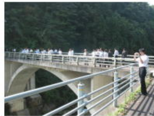
現場見学の様子 (三春ダム直下流の管理橋より)
