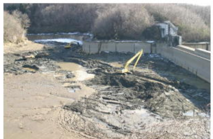
土砂撤去作業状況
