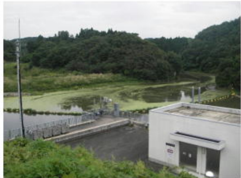
本川前ダム 土砂撤去工前
