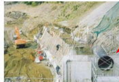
本川前貯水池付近 管設置状況（呑口部）
