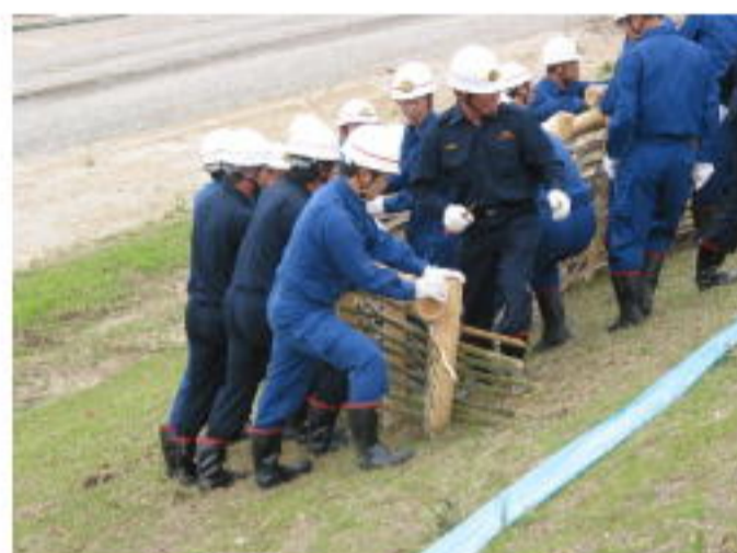
水防工法演習（築きまわし工）
