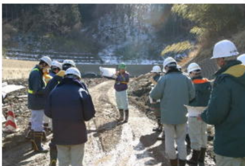
三春ダム周辺整備工事の現場点検の様子
