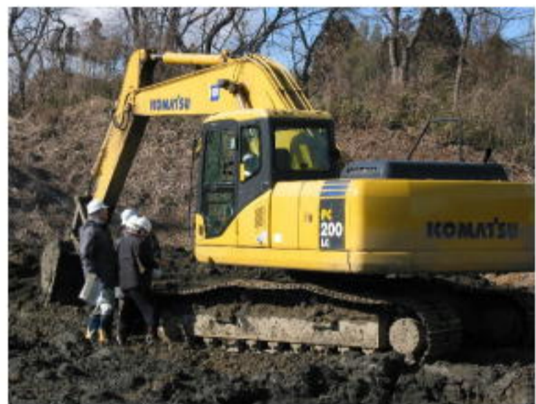
現場点検の様子
