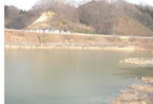
水位が回復した現在の蛇石前貯水池
