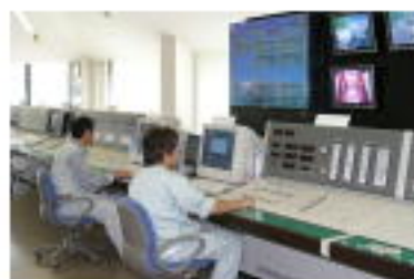
ダム施設操作
