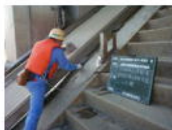
係船設備の点検
