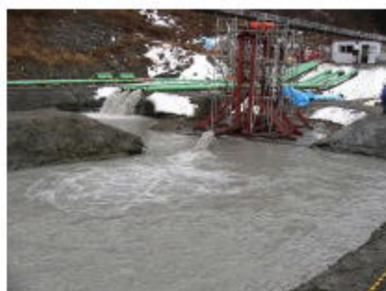
沈砂池（排砂前）
