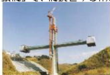
張り出し工法による 主桁施工状況
