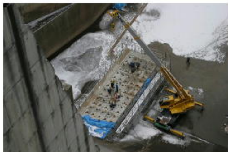
三春ダム堤体下流修繕工事現場 堤体上から撮影
