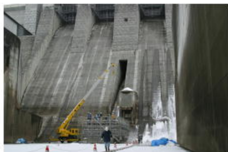
堤体直下の工事現場の様子
