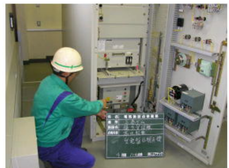
電気施設点検業務の様子
