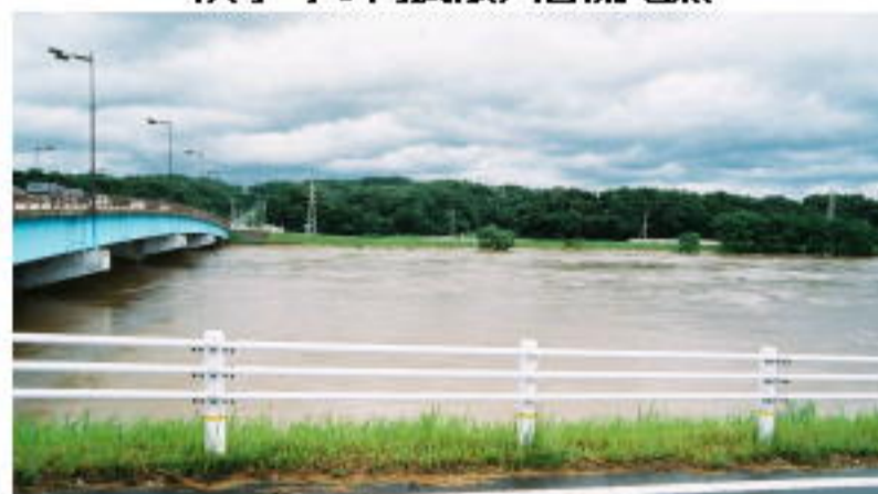
撮影 安原橋付近（郡山市）平成14年7月11日
