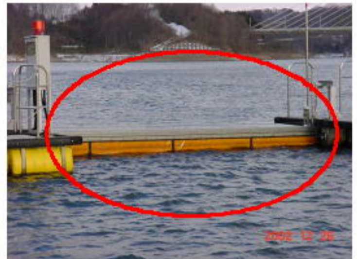
写真1 通船ゲート近景写真
