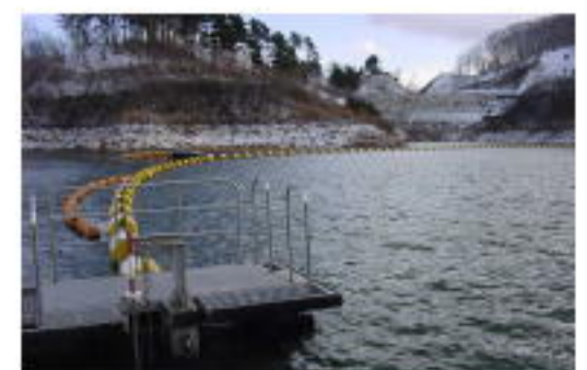
写真②③ 通船ゲートから撮影した網場 （黄色いフロートの連なりが「網場」、オレンジの連なりは「アオコ防止フェンス(ここでは、説明省略しています。)」
