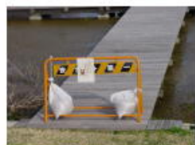
石畑水生生物観察園 (渡り橋損傷の応急処置)
