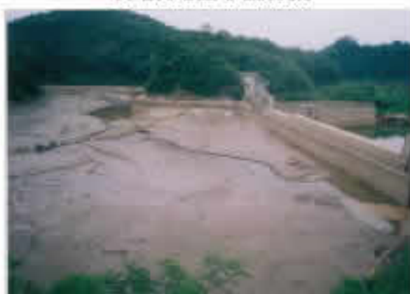
施工前 平成14年7月29日撮影
