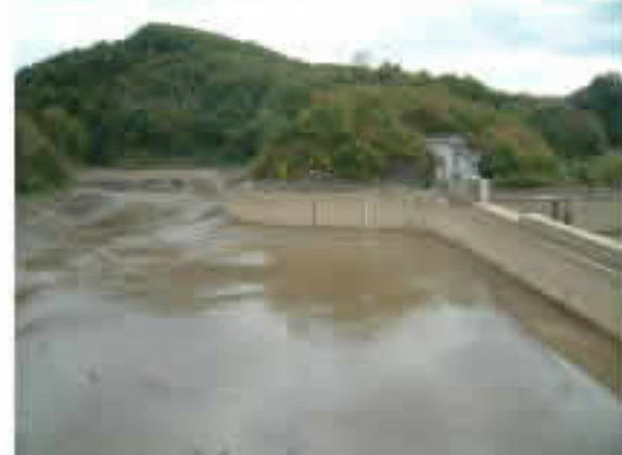
施工後(約39,000 m^3 掘削後) 平成14年10月23日撮影
