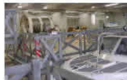
写真④ ワイヤロープウインチ式開閉装置 (写真奥が、ドラム。手前に見えるのが、降台車にのっている巡視船「さくらこ」)
