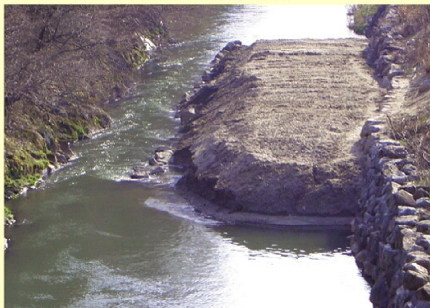
堤体下流土砂還元状況
