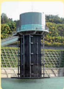
▲郡山上水取水塔
