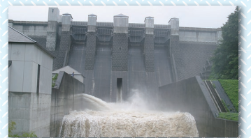
コンジットゲートからの放流 (平成21年8月洪水)
