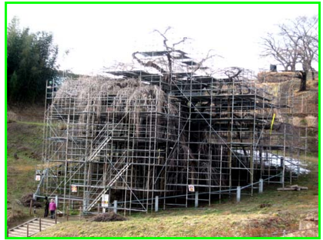
滝ザクラの周りにはまるで建設現場のような足場が組まれていました。
