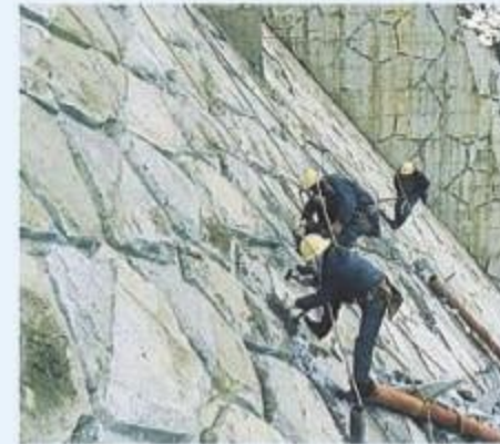
化粧型枠解体状況
