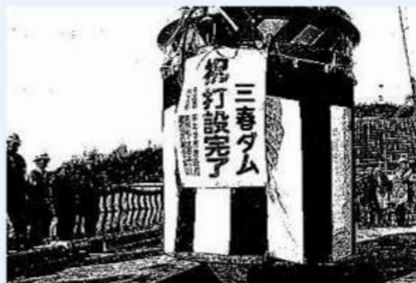
コンクリート最終バケットの打設
