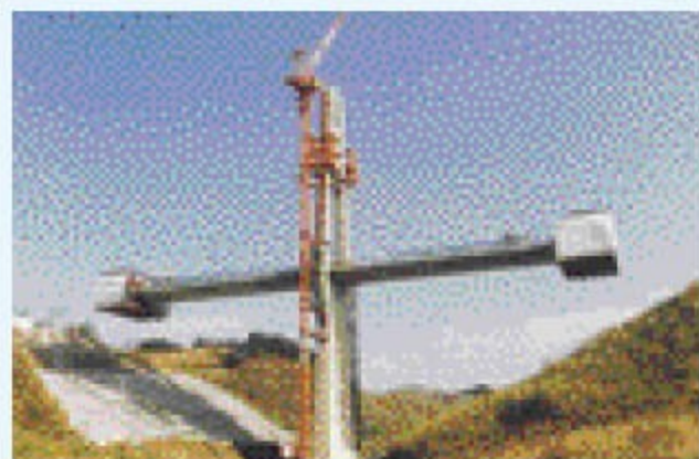
春田大橋 張り出し工法による主桁施工状況
