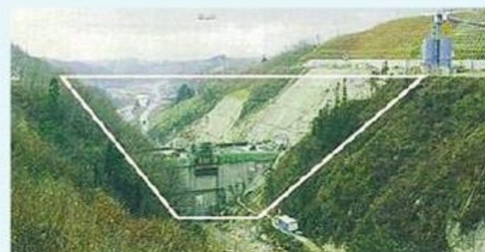
堤体施工状況 平成33年11月
