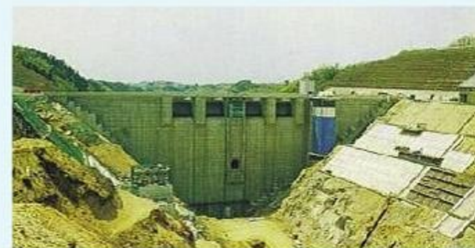
堤体施工状況 平成56年6月
