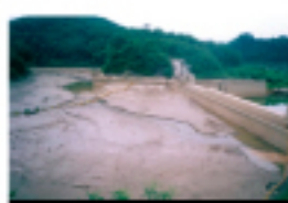
土砂の堆積状況
