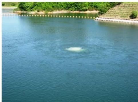
さくら湖でブクブクして見える白い泡の様なものが浅層循環施設で、空気を吹き上げ水を循環しているところです。
